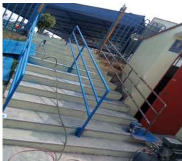
Instalación de barandas en escaleras y rampas.
