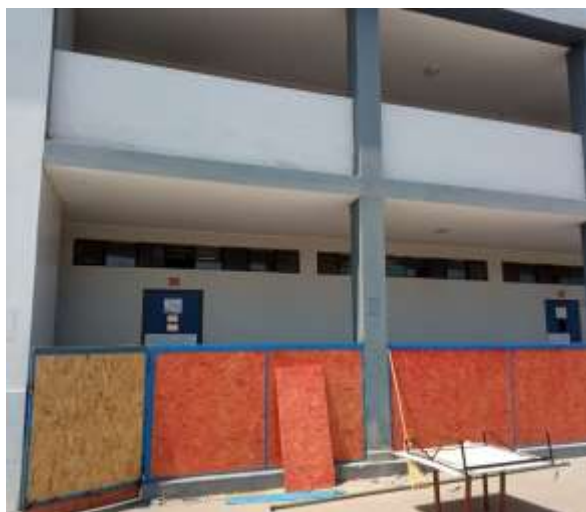
Implementación del cerco perimétrico para aislar edificaciones declaradas no habitable.
